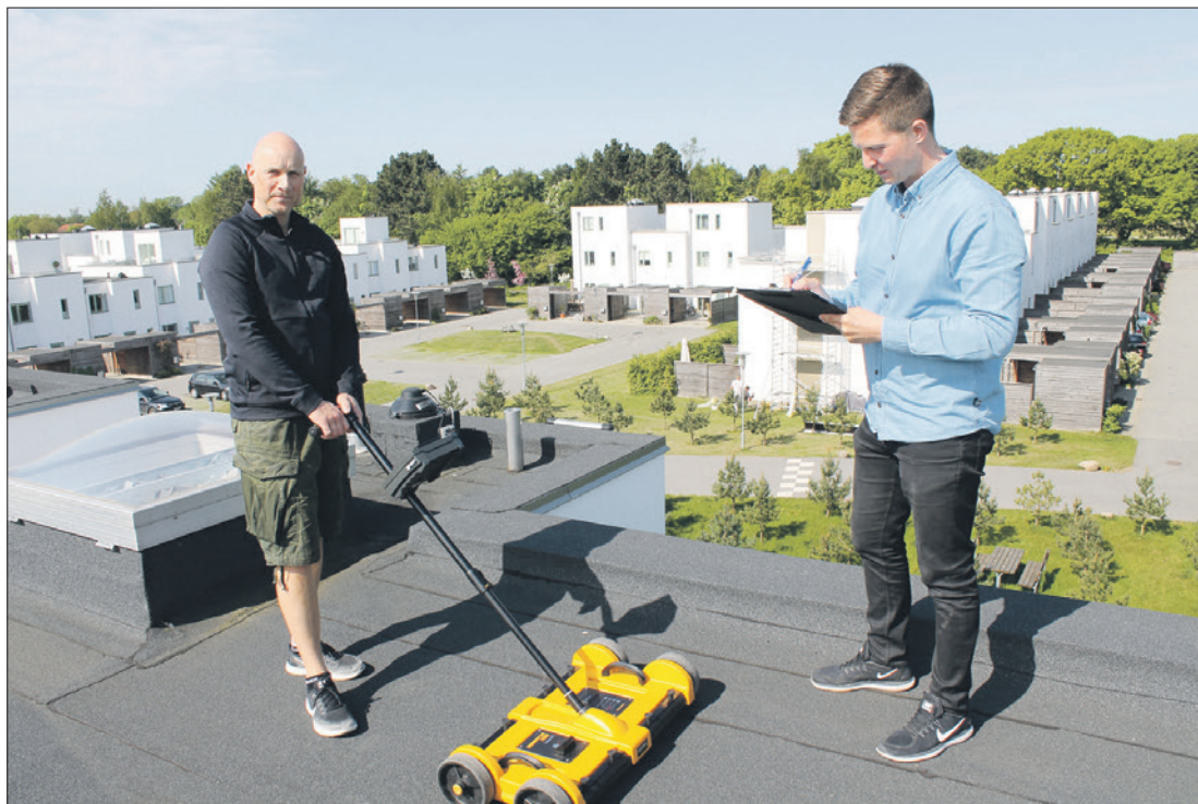
Jonas Kolbe (th) og Svante Emtoft er her i gang med at scanne taget for at se om der er fugt nede i isoleringen.
